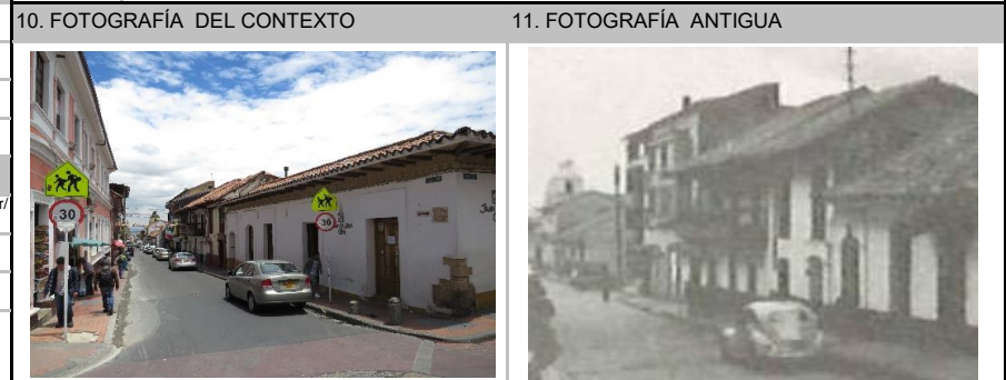
Fuente: Equipo Fotografía PEMP Patrimonio Inmueble
