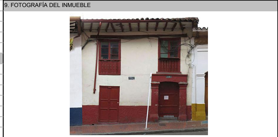
Fuente: Equipo Fotografía PEMP Patrimonio Inmueble
